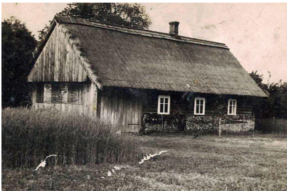
Dom Karoliny Krzysik w Malinówce, wybudowany w 1928 r. Kilka dekad później pożar strawił blisko połowę budynku oraz jego słomianego dachu. To, że akurat spłonął segment, w którym znajdowała się kwatera „Zucha” mogło nie być dziełem przypadku. Właścicielka nie miała środków na jego odbudowę, mieszkała w ocalałej części, która została pokryta eternitem (źródło: archiwum muzeum).
